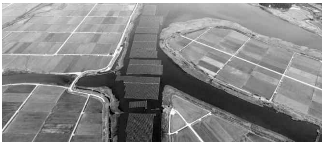
고흥 해창만 일대에 추진중인 수상태양광시설.
