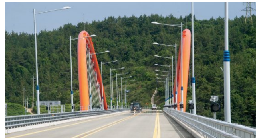
여수시 화정면 낭도와 적금도를 잇는 연도교인 적금대교. 길이 470m, 너비 12.5m다.
