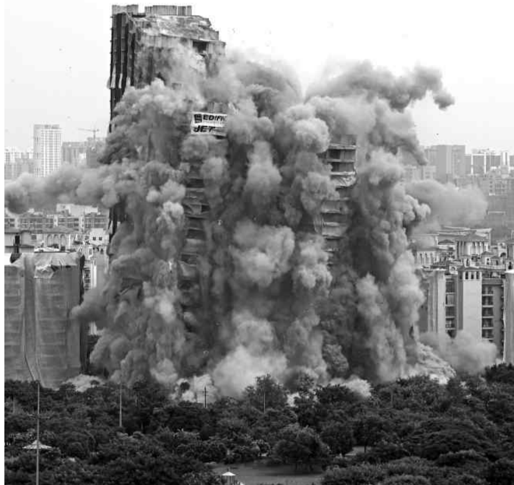
3.7t 폭약에 32층 아파트 와르르 28일(현지시간) 인도 뉴델리 외곽 노아디에 있는 32층짜리 아파트 두 동이 폭파 해체공법으로 철거되고 있다. 현지 언론은 이번 철거를 위해 총 3.7t의 폭약이 사용됐으며 폭파 해체공법을 이용한 철거 중 역대 가장 큰 규모라고 보도했다. 이 건물의 철거는 건설 과정에서 여러 건축 규정과 소방 안전 규범을 위반한 사실이 밝혀졌기 때문이다. /연합뉴스
