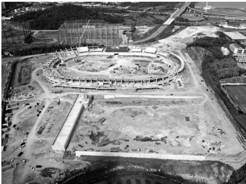
목포종합경기장 건립공사 현장.
