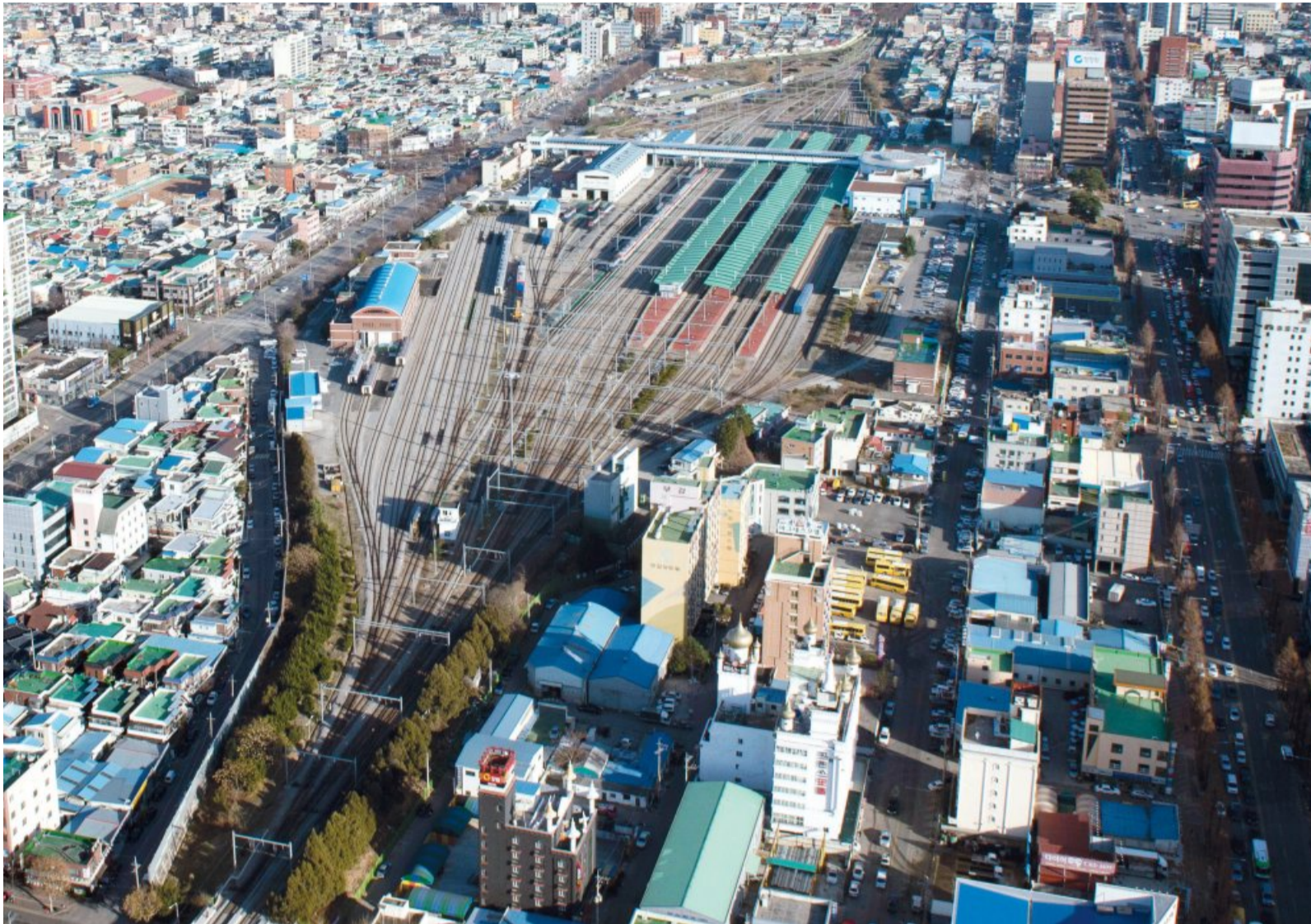
14일 부지 매입 문제로 도시재생사업 등 관련 사업들이 일체 진행되지 못하고 있는 광주역 일대의 전경. 다행히 광주시와 지역 정치권이 땅 소유자인 국가철도공단을 상대로 해당 부지를 매각해달라고 적극 설득한 끝에 긍정적인 답변을 받아냈다. /김진수 기자 jeans@kwangju.co.kr
