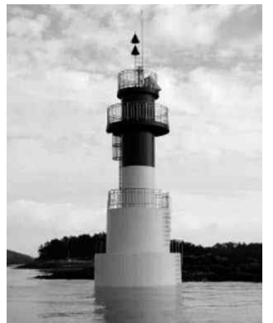
신안군 장산면 북강 선착장 인근에 설치된 서도내기북방등표.
