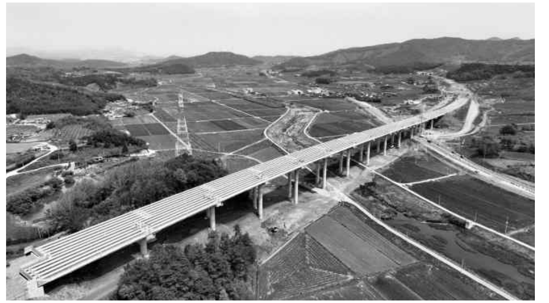
광주-완도 간 고속도로 1단계 구간 공사 현장. <완도군 제공>
