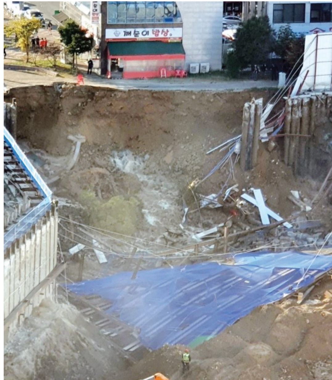
2일 오후 4시께 여수시 웅천동의 ‘웅천 골드클래스 더 마리나’ 공사현장에서 흠막이 벽이 붕괴하면서 주변 지반까지 무너졌다. /여수=김창화 기자 chkim@kwangju.co.kr
