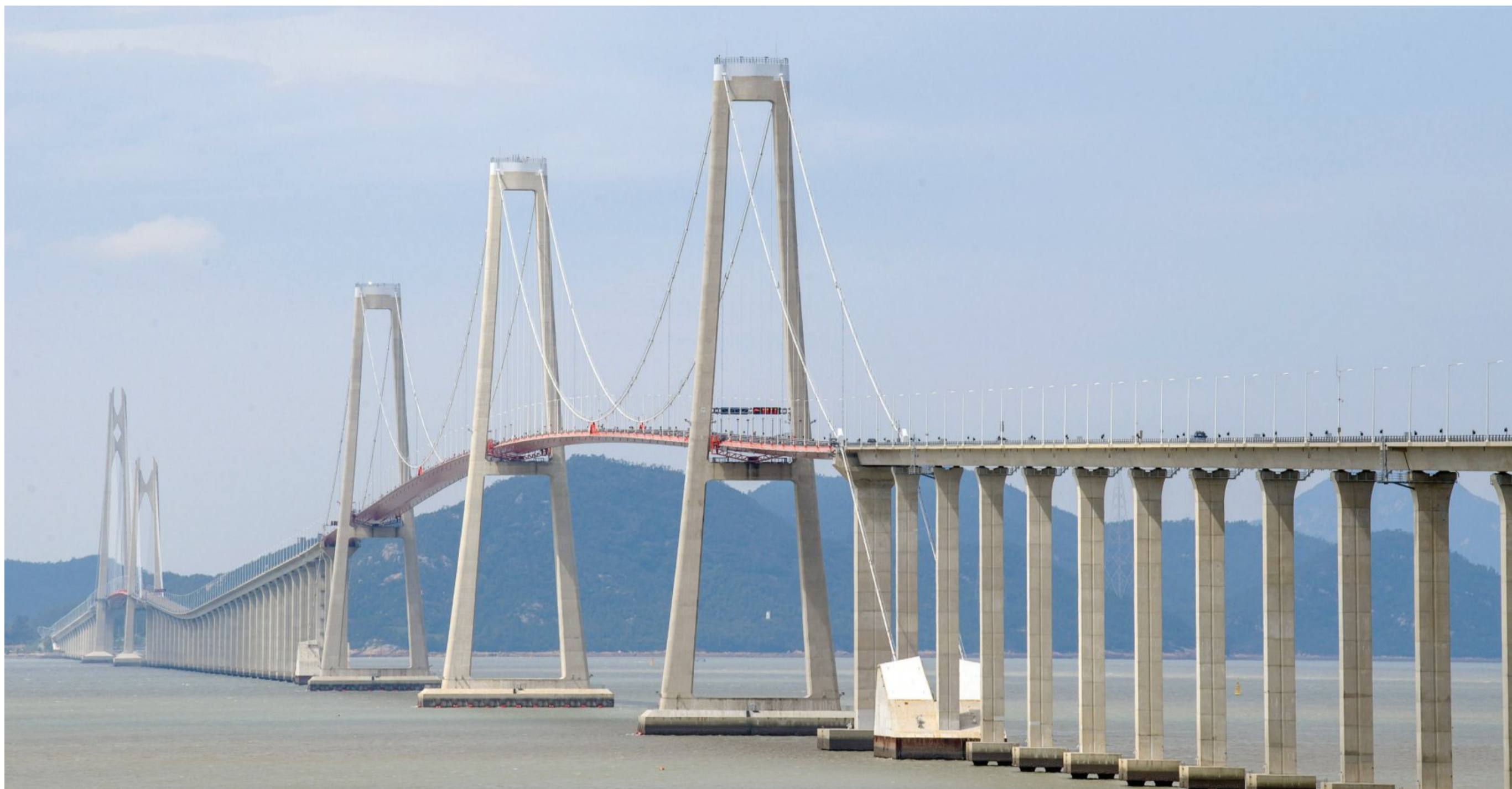
천사대교는 지난 2009년 9월 착공해 10년이 지난 2019년 4월에야 준공됐다. 현수교와 사장교 형식이 공존하는 국내 유일의 교량이며, 총 길이 10.8km, 다리 교량 구간만 7.22km로, 국내 최장거리 해상교량이다. 암태도 측 사장교 길이는 1004m로 신안군 1004개의 섬을 상징하고 있으며, 주탑은 195m로 세계에서 가장 높다.
