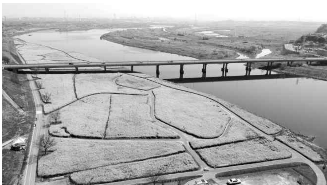
유채꽃 만개한 나주 영산강 둔치 전경.
