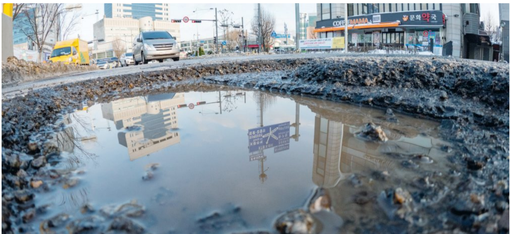
도로 파임 주의하세요 | 광주 동구 금남로에 있는 한 도로에서 28일 제설작업의 여파로 포트홀이 발생했다. 포트홀은 제설제로 녹은 눈이 도로 포장에 침투해 도로 표면의 일부가 부서지는 현상이다. /김진수 기자 jeans@kwangju.co.kr
