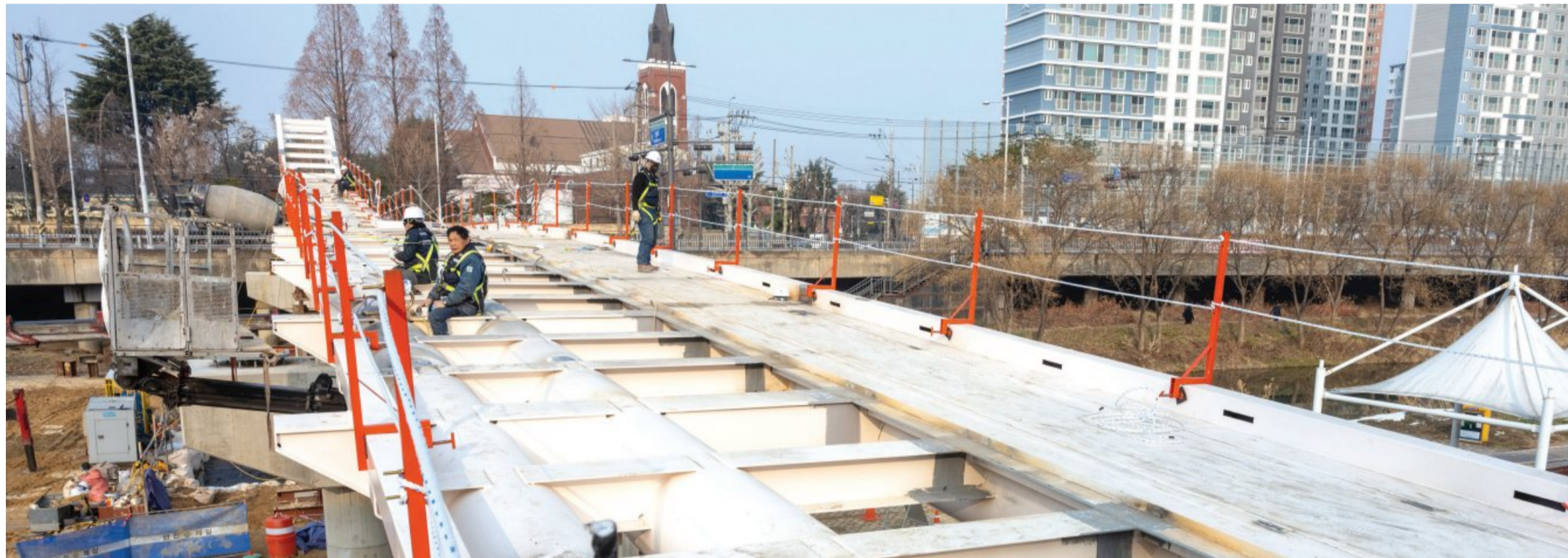
광주 양동 ‘뽕뽕다리’ 새 인도교 8월 완공 과거 구멍 뚫린 철판(안전 발판)을 깔아 다리를 만든 임시가교였던 양동 뽕뽕다리가 8일 오후 65m, 폭 5m의 인도교로 새롭게 만들어지고 있다. 공사관계자들이 다리 상판을 교각에 얹고 작업중에 있다. 뽕뽕다리는 오는 8월 완공 예정이다. /김진수 기자 jeans@kwangju.co.kr
