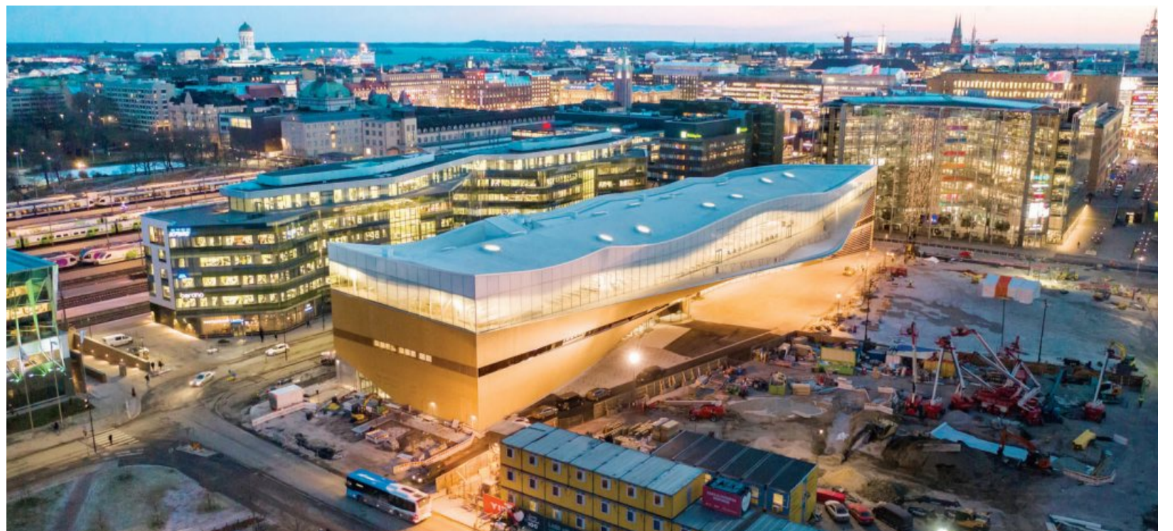
아모스렉스 미술관과 같은 해에 개관한 오디도서관 전경. 도서관의 고정관념을 깬 건축미와 콘텐츠로 유럽을 대표하는 공공도서관으로 부상하고 있다. © Tuomas Uusheimo
