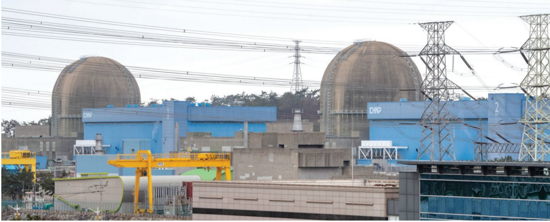
정부가 최근 발표한 제10차 전력기본수급계획을 통해 영광 한빛원전 1호기(왼쪽)와 2호기가 각 10년씩 수명을 연장하기로 했다.
