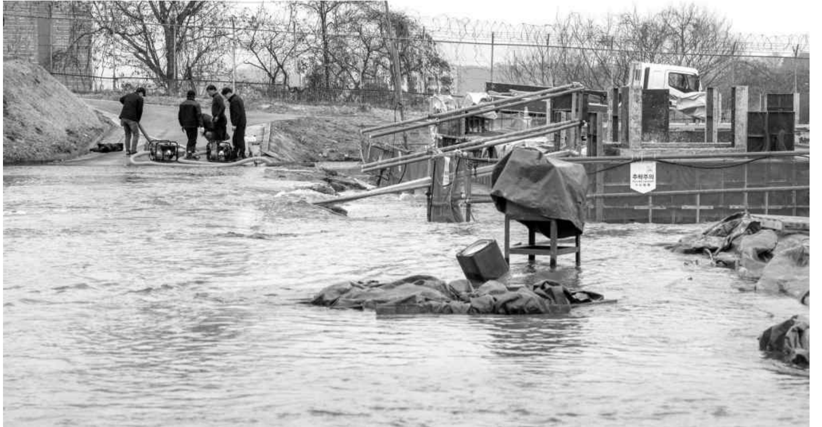
광주시 남구 행암동 덕남정수장 관계자들이 12일 송수관로 밸브 고장으로 넘친 수돗물을 다른 방향으로 돌리기 위해 양수기를 가동하고 있다. /김진수 기자 jeans@kwangju.co.kr
