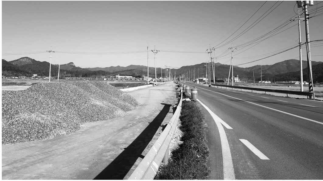
장흥 유치-영암 금정 국도23호선 시설개량사업 현장.
