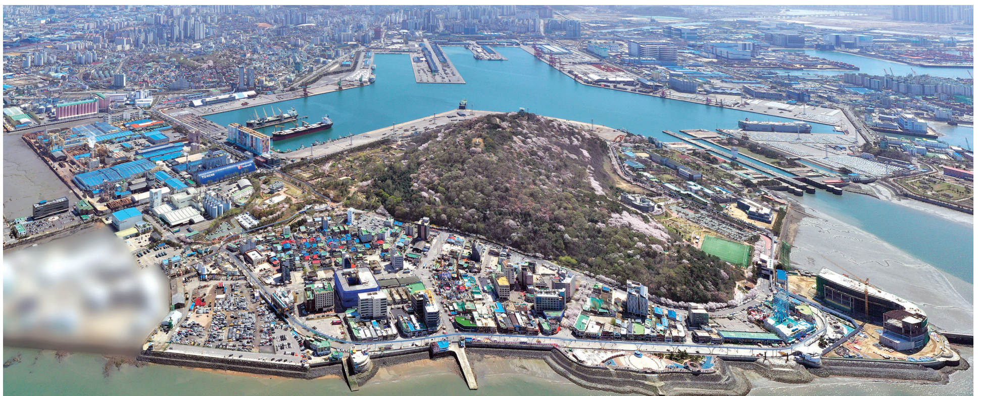
인천상륙작전의 핵심 상륙 지역인 인천 중구 월미도 일대 현재 모습. 폭격 피해를 본 민간인 마을 쪽에는 공원이 들어섰고 주변이 매립되는 등 상륙작전 당시 모습을 찾아보기 어렵다. <경인일보=조재현기자 jhc@kyeongin.com>
