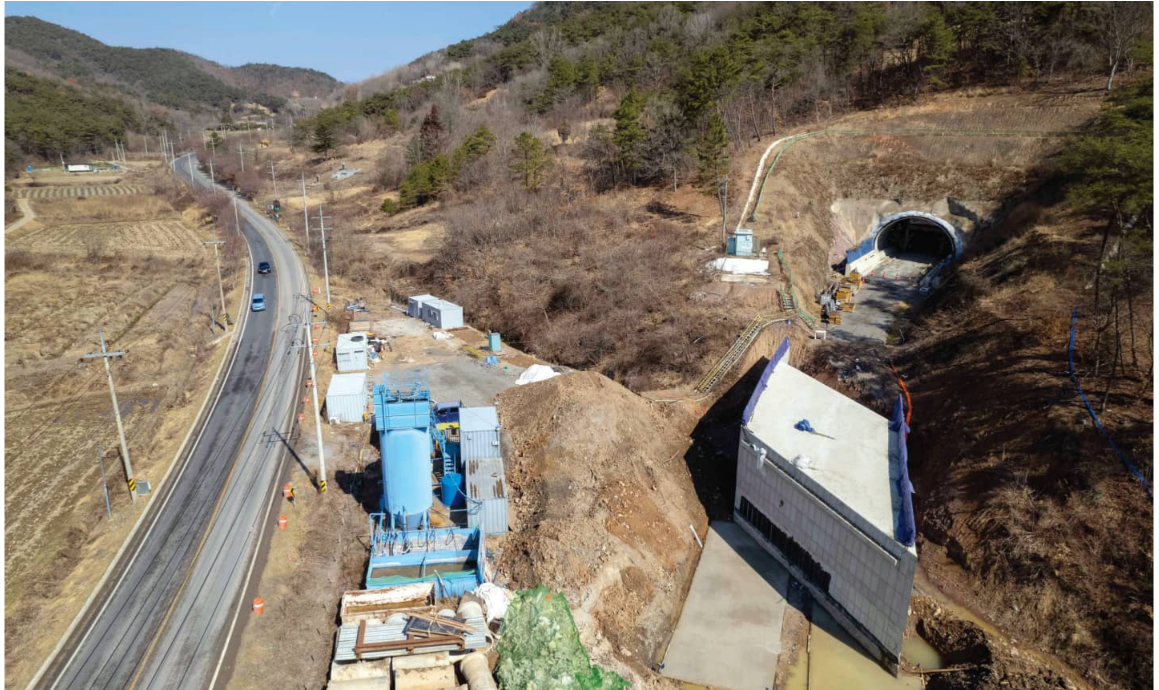
국도 15호선에서 가장 선형이 구불구불해 사고 위험이 큰 화순 동면~순천 송광 구간에 대한 공사가 20년만에 착수됐다. 기존 15km를 7.32km의 직선으로 연결하면서 교통 편의성이 크게 높아질 전망이다. 사진은 국도 15호선 공사 현장.
