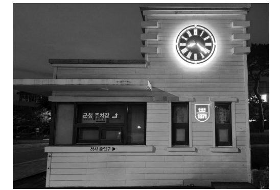
담양군청에 설치된 ‘자율형 건물번호판’.
