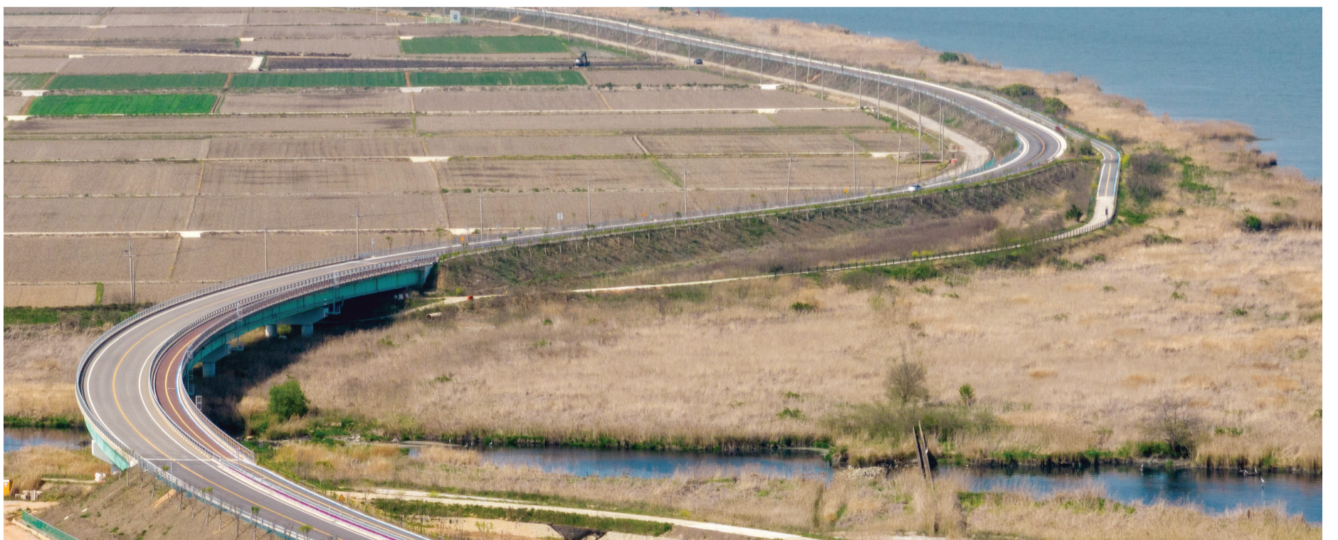
영산강 강변도로 2-2단계는 1공구(5.70km)와 2공구(7.52km)로 나뉘어 진행된다. 모두 1523억 원이 투입되며, 공사기간은 5년이다.
