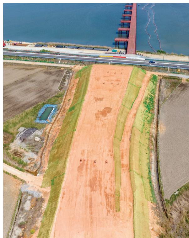
2-1단계 구간인 무안 몽탄 당호라-일로 북룡리 구간(4.66km)은 지난 2016년 공사에 들어가 2022년 8월 준공했다. 영산강 강변도로 미개통 구간.
