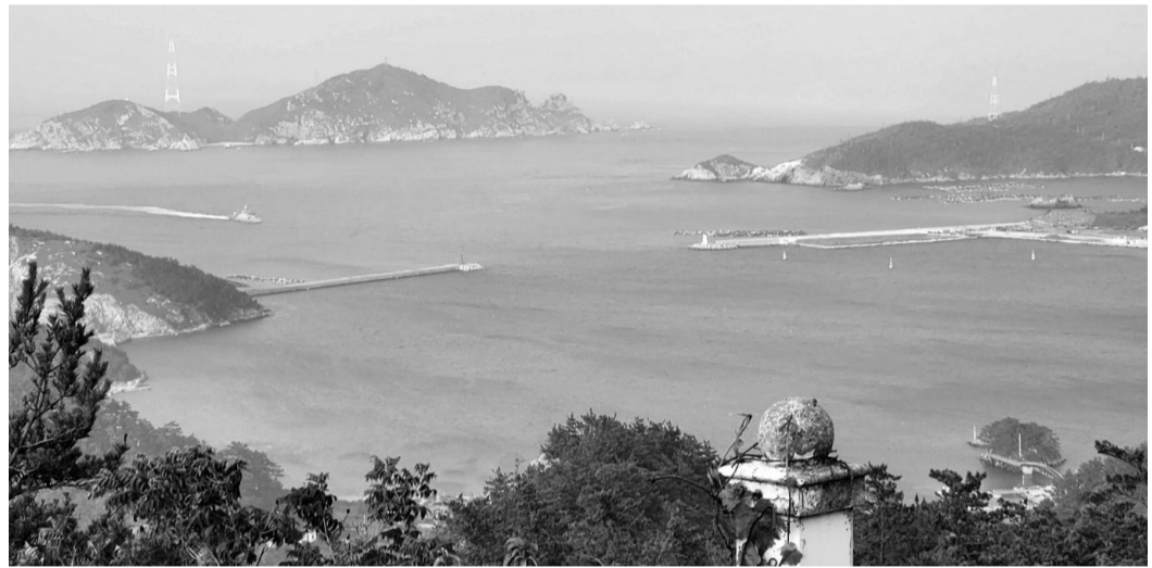
항 내 양식시설 철거가 완료돼 환한 분위기를 연출하는 흑산도항(여리항) 전경.
