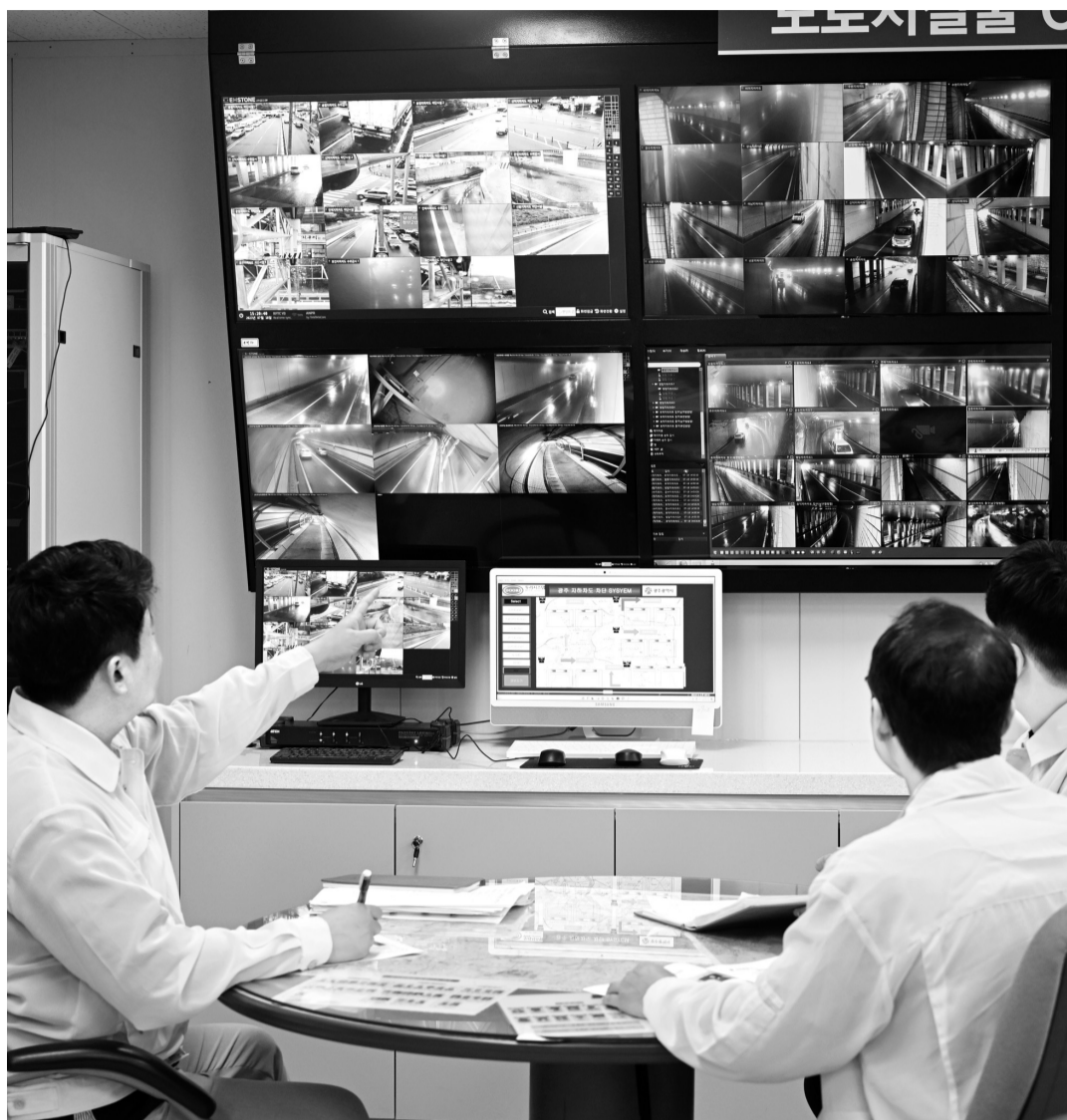
연일 폭우가 내리고 있는 18일 광주시 서구 광주종합건설본부 상황실에서 구조물관리팀 직원들이 15개 지하차도를 24시간 상주하며 모니터링하고 있다. /나명주기자mjna@kwangju.co.kr
