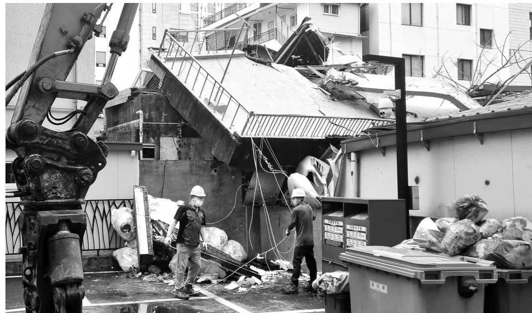
호우에 붕괴된 상가 24일 광주시 동구 충장로의 빈 상가가 집중호우로 붕괴됐다. 광주시 동구는 건물이 50년 넘는 세월을 노후하면서 빗물이 벽체 등으로 스며들어 붕괴 사고로 이어진 것으로 보고 25일까지 건물 잔해를 철거하기로 했다. /나명주기자mjna@
