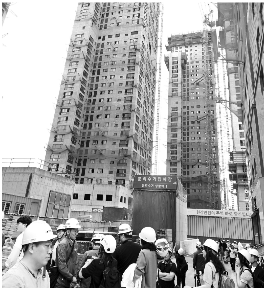
HDC현대산업개발은 2일 '부분철거' 논란을 빚었던 광주 서구 화정동 아이파크 아파트 철거 공사와 관련해 입주예정자 의견을 받아들여 1~3층 상가를 포함한 지상층을 전면 철거하기로 결정했다. 철거 작업이 이뤄지고 있는 화정아이파크 아파트 공사 현장 모습. /나명주 기자 mjna@kwangju.co.kr
