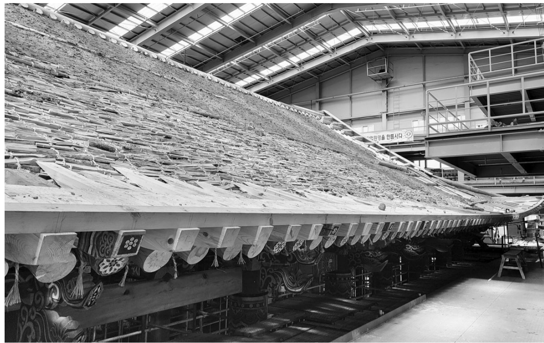
여수시가 선사시대부터 임진왜란, 근현대에 이어지는 방대한 역사자원을 활용한 '문화 향유 도시' 만들기에 나선다. 내년 말 보수를 마무리하는 국보 진남관의 지붕 공사 모습.
