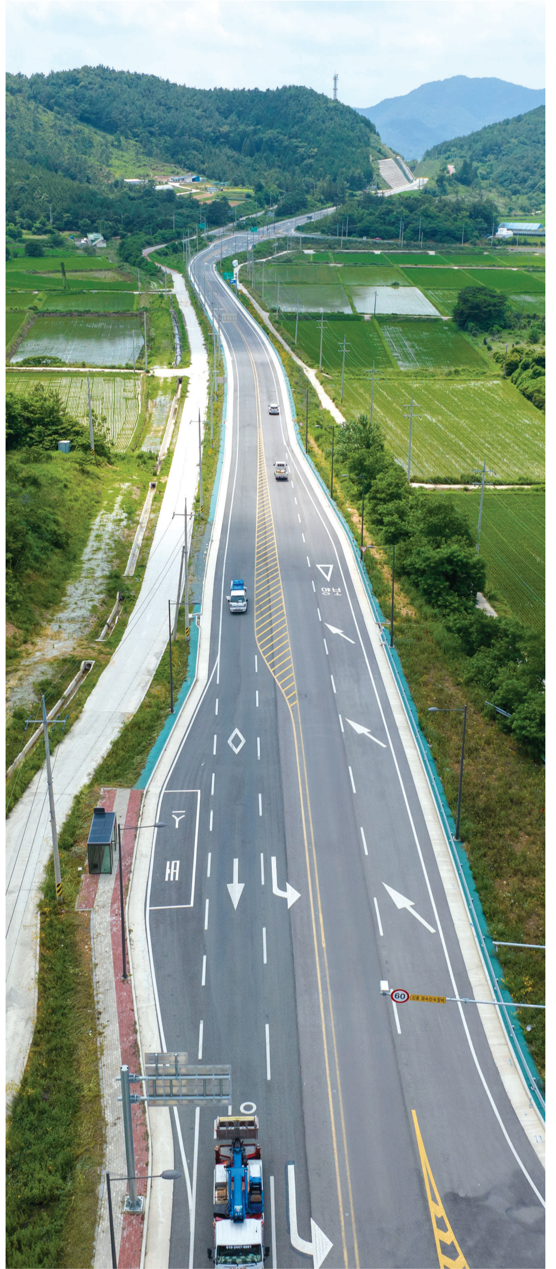
지난 2017년 사업비 377억 원을 투입돼 시작된 해남군 옥천면 송운교차로~강진군 도암면 계라교차로(연장 5.7km)의 2차로 시설개량공사가 지난 2022년 2월 준공됐다. 이 구간은 국도 시설 기준에도 미치지 못할 정도로 열악했다.
