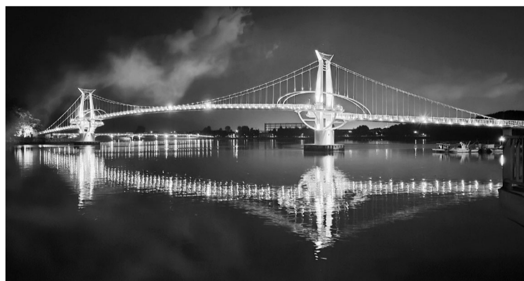
광양 배알도를 잇는 별해는다리와 해맞이다리에 화려한 조명이 불을 밝히고 있다. 광양시는 3주간 시범 운영을 거쳐 지난 25일부터 본격적으로 야간경관조명(일몰~밤 11시)을 운영한다. <광양시 제공>
