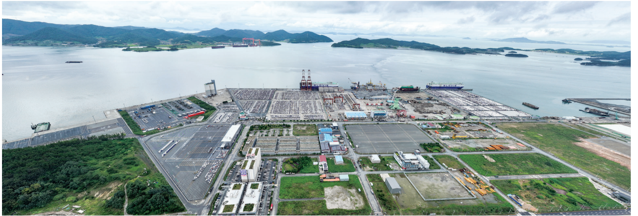
세계 최대 풍력발전 터빈 기업인 덴마크 '베스타스'의 터빈 공장 건립을 계기로 목포 신항만을 자유무역지구 및 기회발전특구로 지정, 국내외 풍력발전 소재·부품 기업들의 아시아 진출 전초기지로 키우는 방안이 추진되고 있다. 30일 하늘에서 본 목포 신항만 전경. /목포=김진수 기자 jeans@kwangju.co.kr
