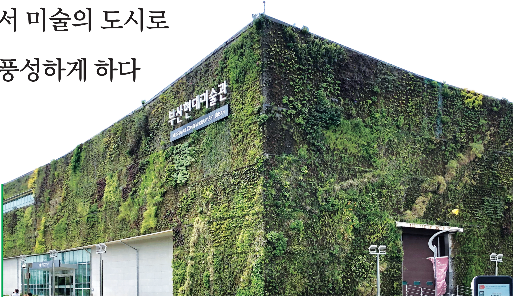
부산시 사하구 을숙도에 자리하고 있는 부산현대미술관전경. 벽면녹화의 세계적인 거장인 패트릭 블랑이 175종의 식물을 심어 수직정원으로 조성한 외벽이 인상적이다.
