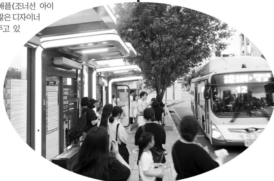
ACC 인근에 설치된 ‘LED 버스 정거장’.
