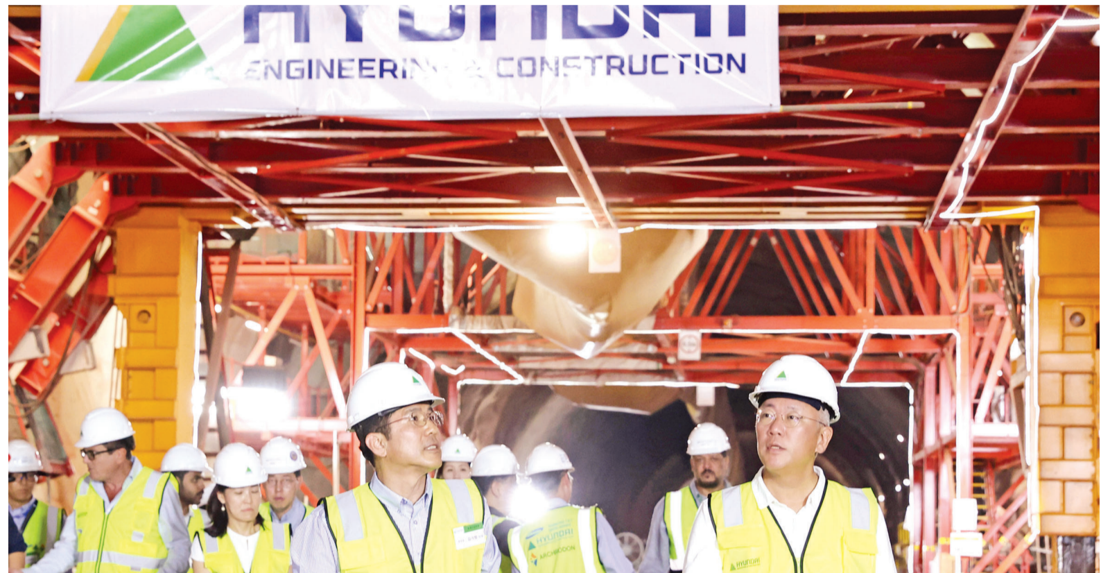
정희선(오른쪽) 회장이 사우디 서북부 타북주에 조성 중인 내움시티의 주거공간인 '더 라인' 구역 내 현대건설 지하터널 건설 현장을 둘러보고 있다. <현대차그룹 제공>
