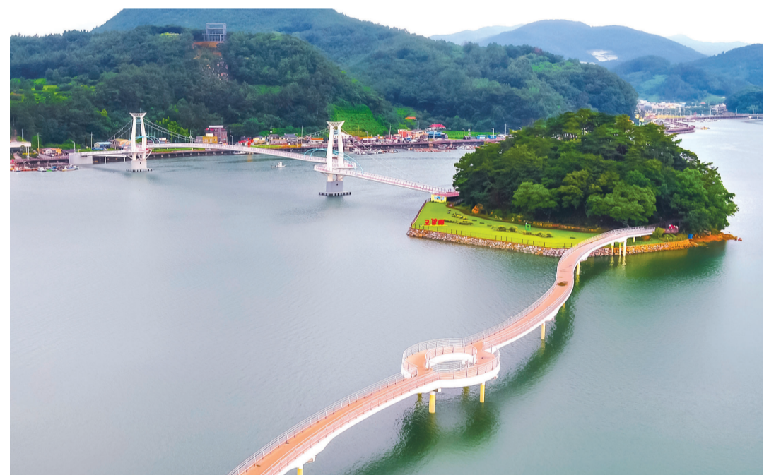
배알도와 망덕포구를 잇는 '해맞이다리'와 '별헤는다리'는 매일 해가 진 뒤 밤 11시까지 1605개의 조명을 별처럼 밝힌다.
