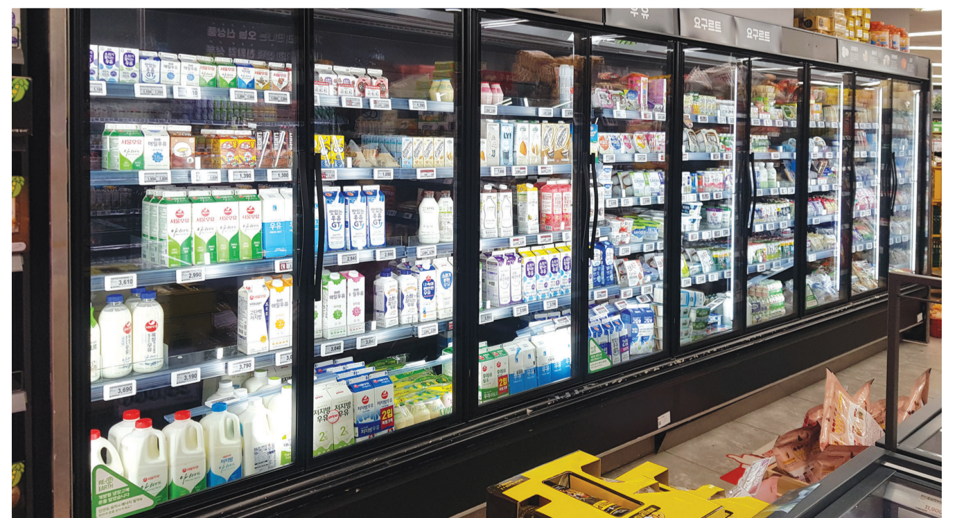
한전은 지난해 7월부터 에너지 효율을 위해 소상공인 등이 운영하는 식품 매장의 개방형 냉장고에 냉장고 문닫기 사업을 벌이고 있다. 사진은 푸드마켓 개방형 냉장고에 에너지 효율을 위해 문을 설치한 모습. (한전 제공)
