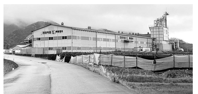
농식품부 공모사업에 선정된 영암축협 섬유질 사료공장 전경.
