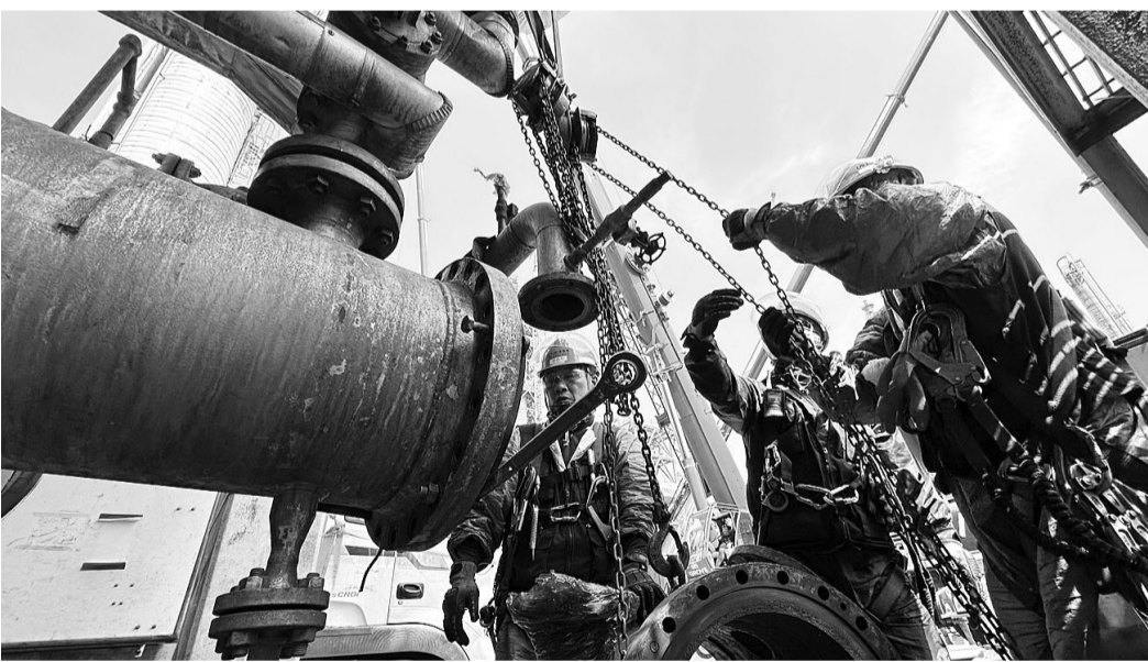
GS칼텍스 여수공장에서 작업자들이 견인 장치를 활용해 대정비 작업을 하고 있다. <GS칼텍스 제공>
