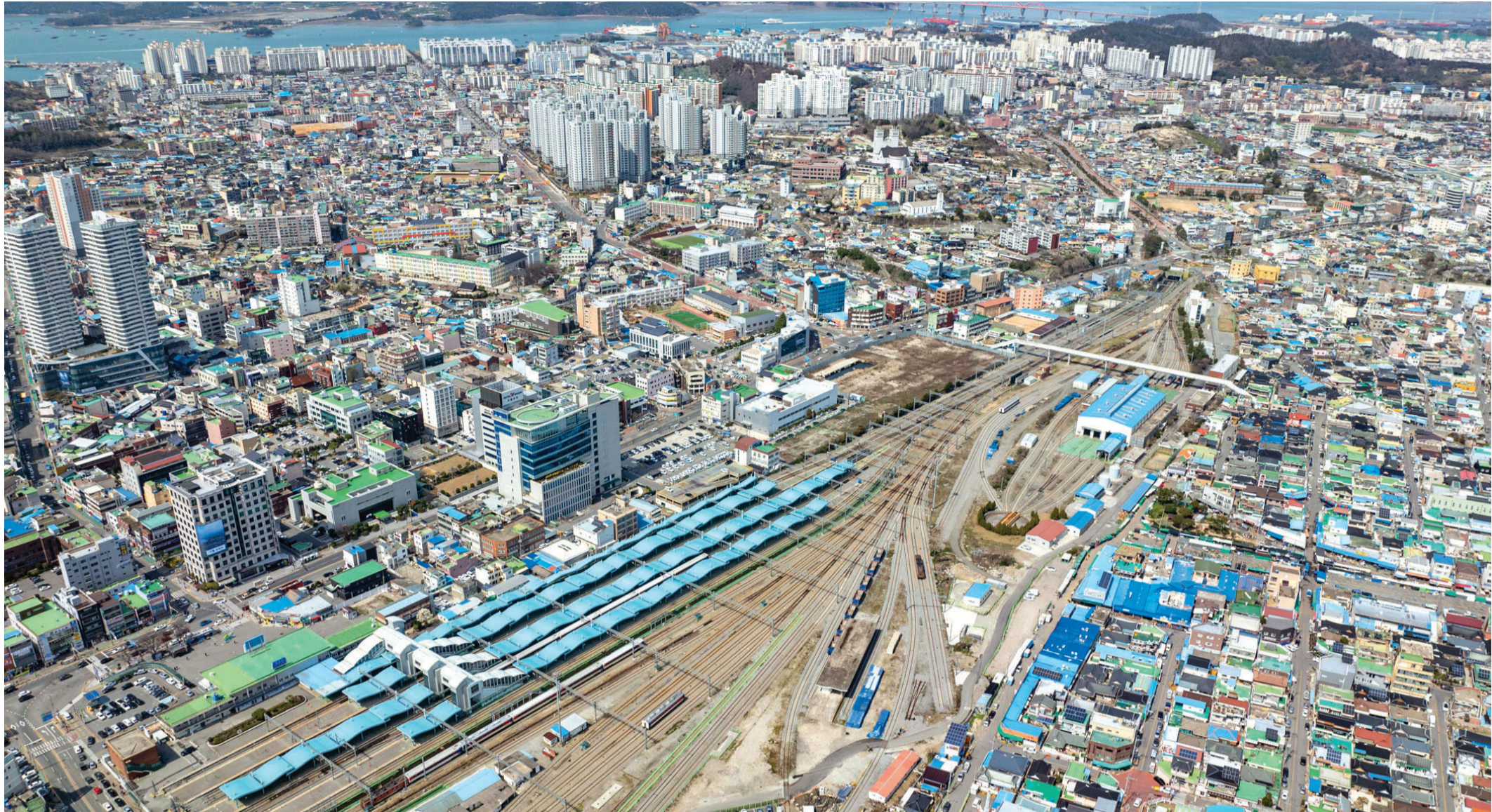
호남고속철도 종착역인 목포역은 오는 2028년까지 철도시설 전면 재배치 사업을 마무리한다. 사진은 목포역과 목포 구도심 전경.
