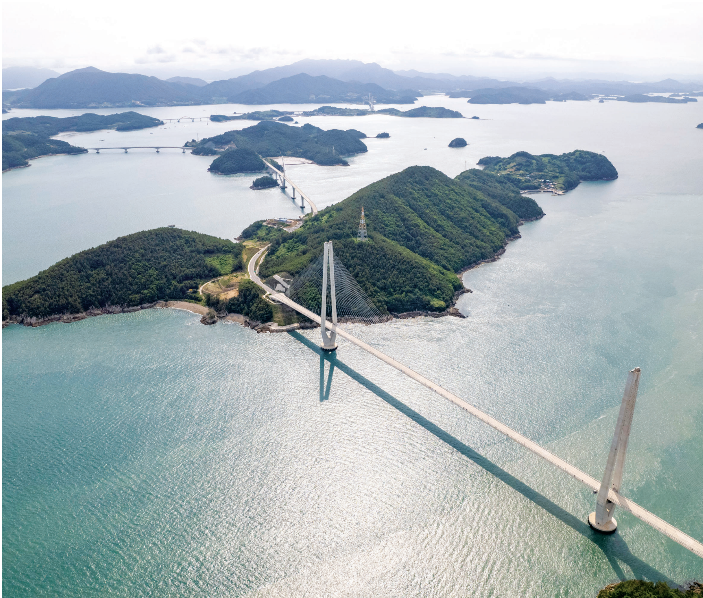
여수시 돌산읍 신복리에서 고흥군 영남면 우천리까지 11개 해상 교량으로 연결되는 '섬섬백리길' 중 조발대교다. 멀리 고흥 영남면 팔영대교에 이어진 적금대교, 낭도대교, 둔병대교 등도 한 눈에 들어온다. 총연장은 39km으로 현재 7개의 교량은 이미 운행 중이고, 나머지 4개 교량도 2027년에 완공될 예정이다. 광주일보는 수도권, 영남권 등 타 지역보다 호남의 발전이 더딘 이유를 이 같은 교량, 도로, 항만, 공항 등 기본적인 국가기반시설의 미흡에서 찾고 있다. 광주일보는 절대적으로 부족한 국가기반시설 확충을 위해 전라도를 비롯한 각 지자체와 함께 전력을 기울이고 있다. /김진수 기자 jeans@kwangju.co.kr
