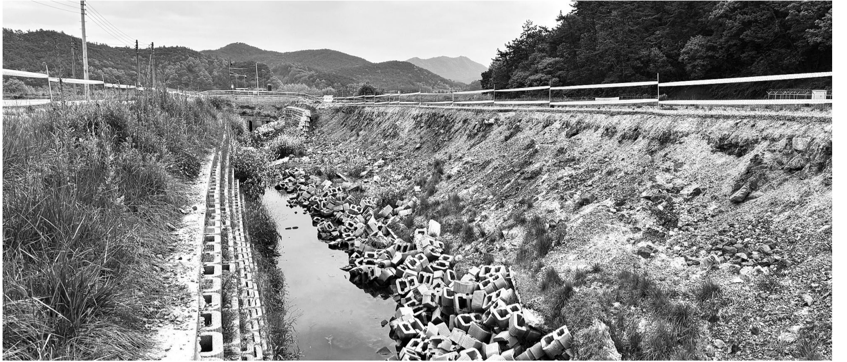
함평군 대동면 금곡리와 상곡리의 논과 밭을 연결하는 수로 일부 구간이 지난해 수해로 블럭과 제방이 무너진 채 10개월째 방치돼 있다.
