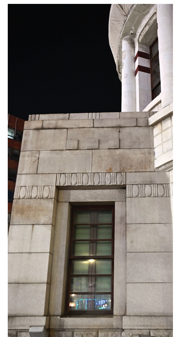
인천우체국은 조적조 건축임에도 석조 건축의 외관을 갖춘 서양식 역사주의 양식을 따랐다. 인천우체국 정문 측면부. /경인일보 DB
