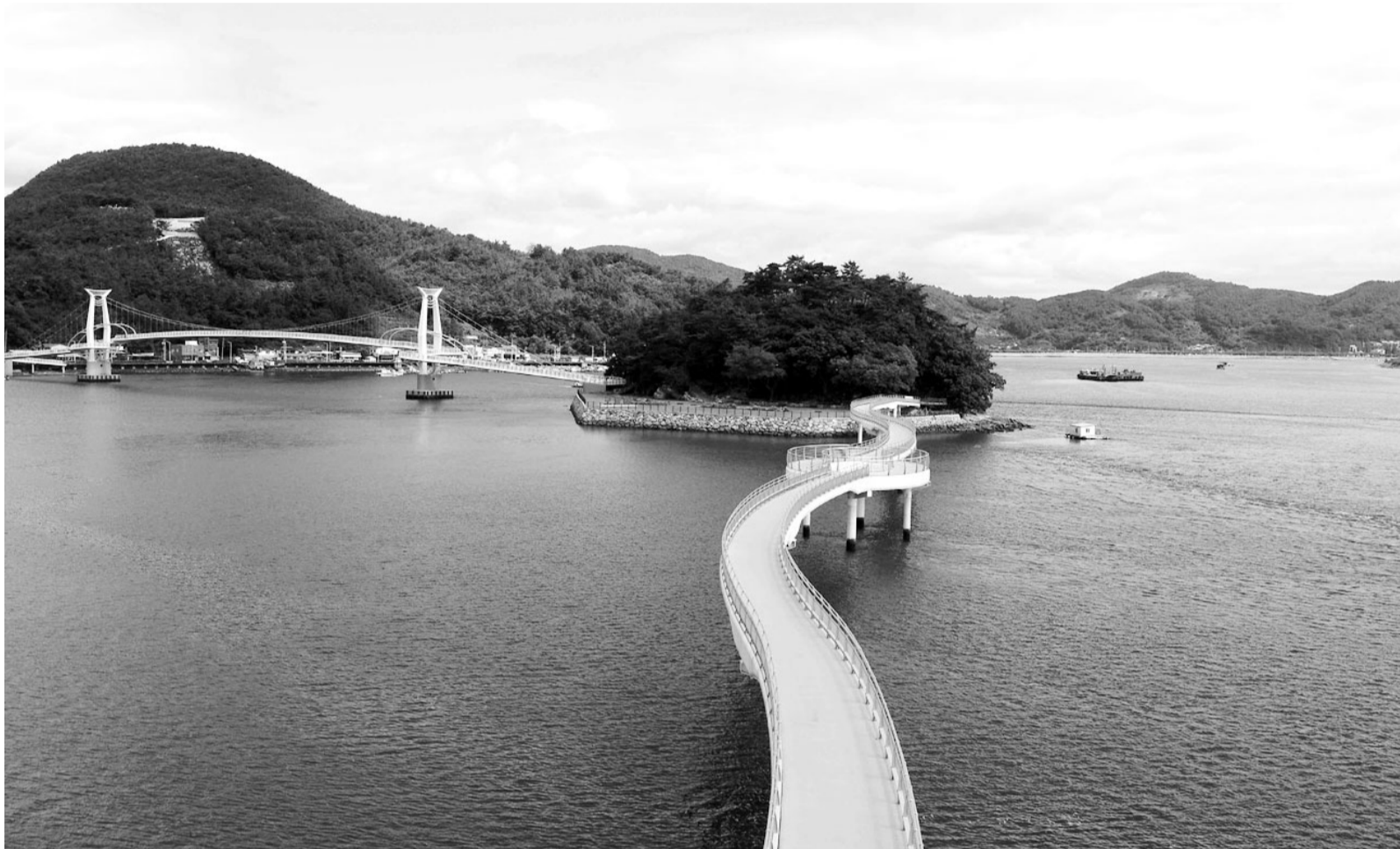
광양 '남파랑길' 49구간을 지나는 '별 헤는 다리' '배알도 섬 정원' '해맞이 다리' 사이로 섬진강이 흐르고 있다. <광양시 제공>
