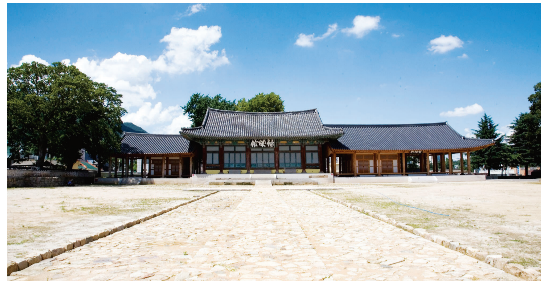
140년 만에 해체 보수를 추진하는 조선시대 최대 규모 객사 '나주 금성관' 전경. (나주시 제공)
