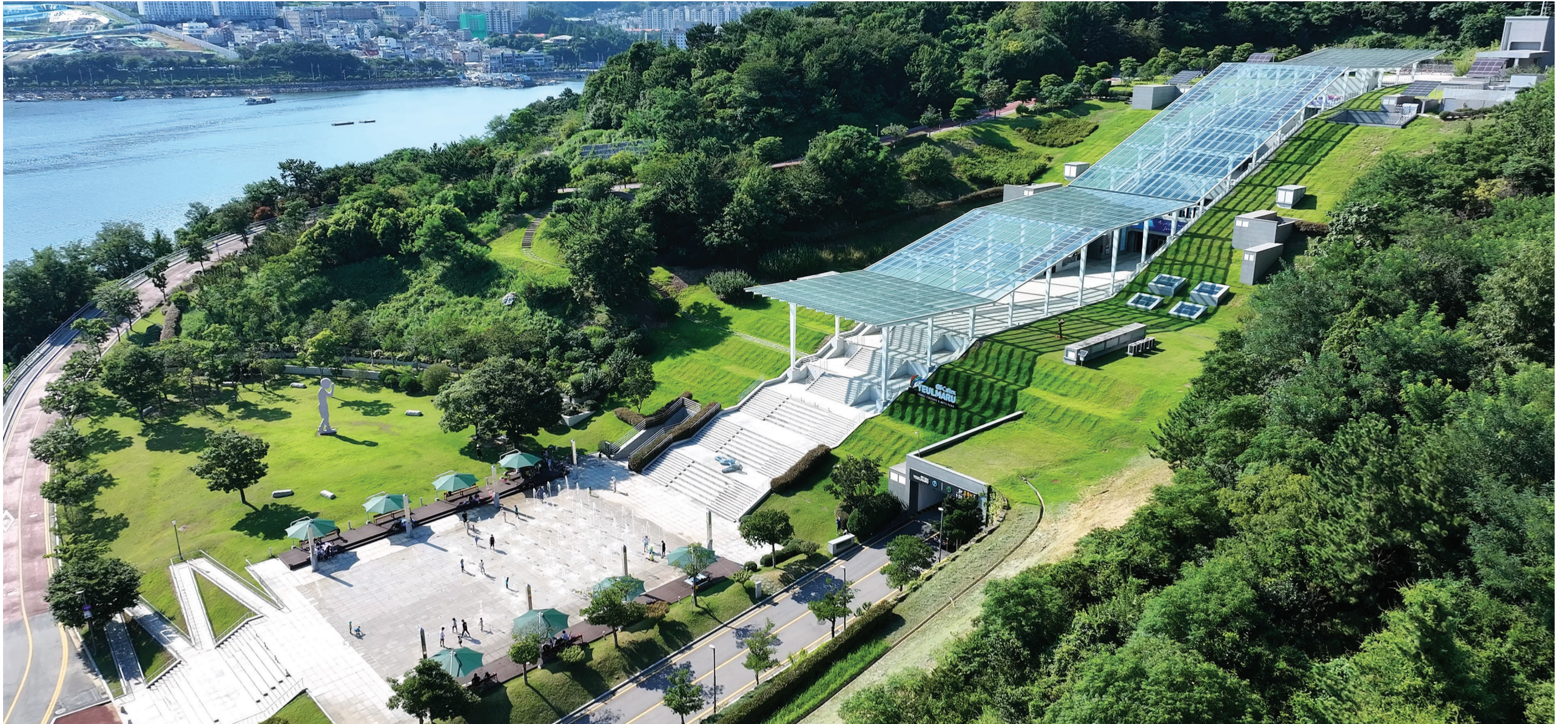
세계적인 건축가 도미니크 페로가 설계한 여수 예술마루는 산과 바다가 어우러지는 '하나의 커다란 산책로'를 콘셉트로 삼았다. 산 정상부터 물이 흐르는 듯한 느낌을 자아내는 152m의 유리 지붕은 예술마루의 트레이드 마크다. <GS칼텍스 예술마루 제공>
