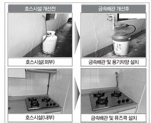
호스시설 개선전(왼쪽)과 개선후(오른쪽) 모습. 금속배관 및 용기차양 설치 모습도 보인다.
