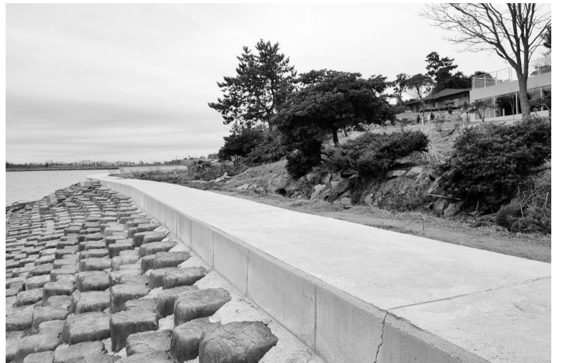
A법인의 사업장 앞 현경면 오류리 곡지지구 연안정비 사업 구간. 다른 구간과 달리 이 구간은 파라펫 시공을 하지않고 스텝블록으로 공사했다.
