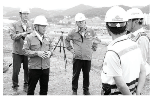
복구를 위한 수방자재를 충분히 확보하고 사고예방에 만전을 기하겠다"고 강조했다. 한편 전남개발공사는 지난 5월 재난관리에 기여한 공을 인정받아 '2024년 국가재난관리유공' 국무총리표창을 수상한 바 있다.
