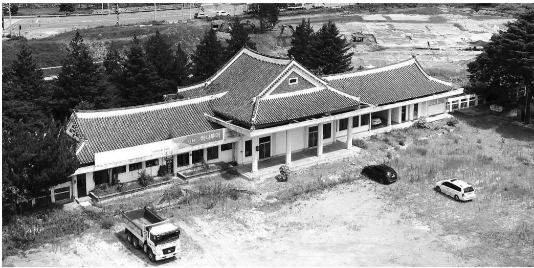
남원 만인공원이 조성 중인 옛 남원역사 부지.
