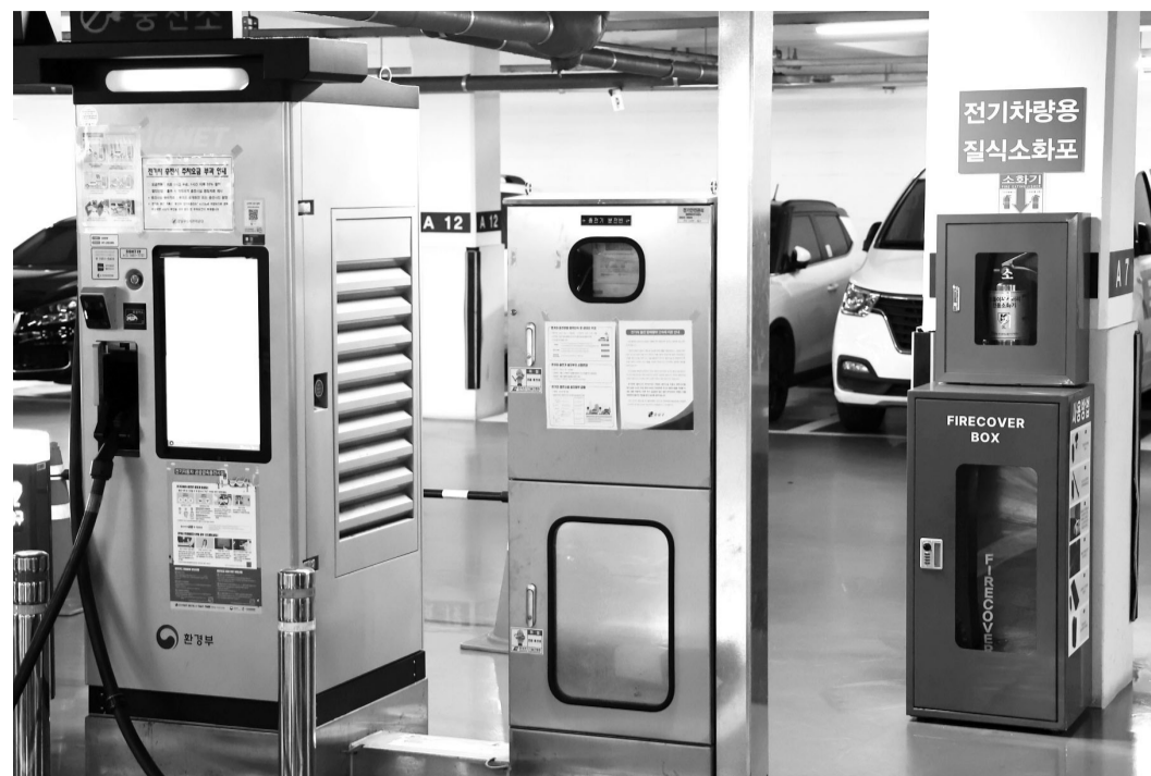
전기차 화재 대응 ‘질식소화덮개’ 설치 11일 서울 강남구의 한 공동주택에 전기차량 화재용 질식소화덮개가 설치돼 있다. /연합뉴스
