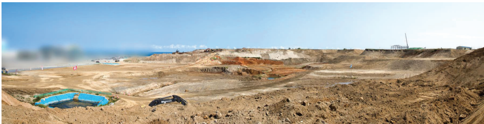
경상북도 울진군 한국수력원자력 한울원자력본부의 신한울 3·4호기 건설 부지. 현재 터파기 공사가 마무리된 상태로 한수원은 건설 허가와 동시에 본격적인 공사에 들어간다. <한국수력원자력 제공>
