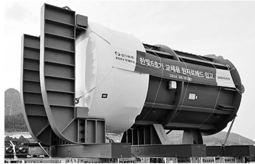
한빛6호기 교체용 원자로 헤드가 지난 8월 14일 안착대로 이동하던 작업 중 임시덮개 위로 추락했다. <한국수력원자력 제공>
