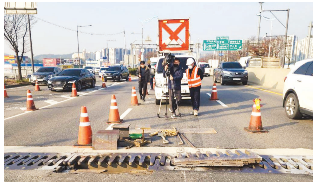
광주시 종합건설본부 관계자들이 21일 광주시 광산구 어등대교(시청 방면) 2차로에서 파손된 신축이음장치를 보수하고 있다. (광주시 제공)
